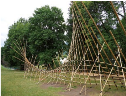
Morphosis : une structure en bambou à construire, à admirer ou dans laquelle grimper
